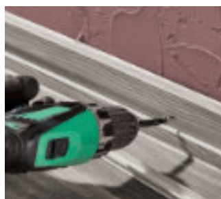
Na kolki rozporowe Wall plug installation Mit Dübeln
